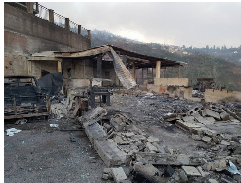
Incêndios: 300 pessoas desalojadas no Funchal já têm habitação provisória
